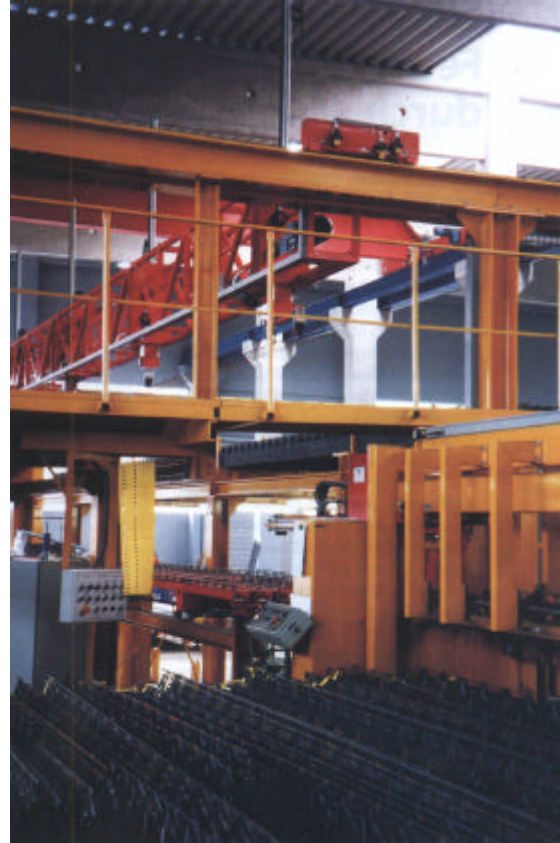
Positionierung der fertigen Gitterträgerpakete zur Plattenfertigung auf dem Trägerauslauf. Ein Kettenband puffert die Stapel für die Handentnahme.
